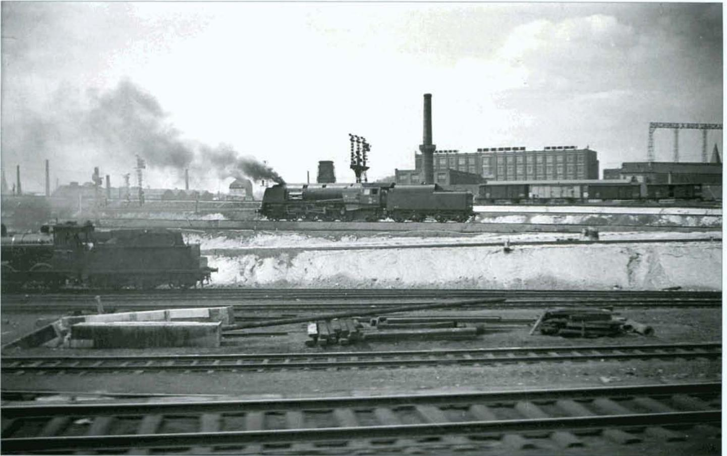
↑ **PHOTO 118-45 NB** Vers 1936, travaux de surhaussement du plan des voies en vue de la construction de la Jonction Nord-Midi. Au milieu de l'image, on voit la type 1 n° 101 évoluant. Les installations de la remise de Bruxelles-Nord débutaient à gauche de la type 1. Photo Phil DAMBLY, collection PFT.
