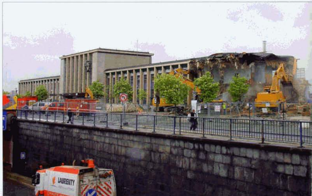
↓ PHOTO 116-99 La démolition de la gare de Mons a été menée à bien de mai à juin. Le 14 mai, la démolition de la gare vient de débuter. Pierre HERBIET.
