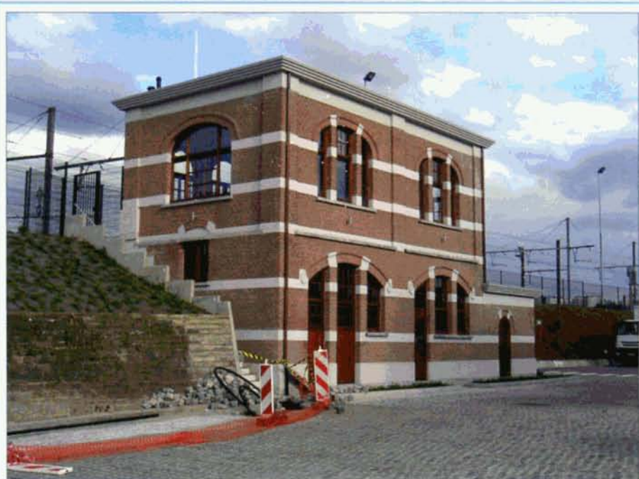
Rénovation de la cabine de Cureghem
