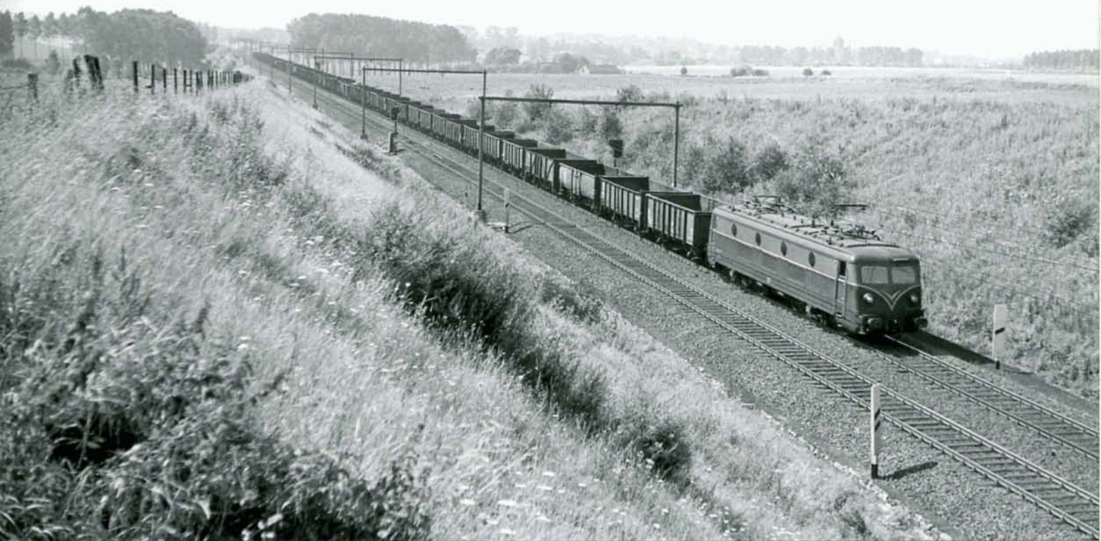
PHOTO 114-44 NB La ligne Bruxelles - Mons fut mise sous tension le 25 mai 1963. Cette électrification fut prolongée jusqu'à Quévry le 9 septembre 1963 et Saint-Ghislain le 25 novembre de la même année. Les 123 trouvèrent dès ce moment un nouveau terrain d'action, non seulement en trafic marchandises, mais également voyageurs. Le 13 août 1965, une 123 non identifiée remorque une rame de tombereaux vides vers Bruxelles. Le train vient de passer la gare de Braine-le-Comte et se dirige vers Hennyères. Photo Bruno DEDONCKER, collection PFT.
