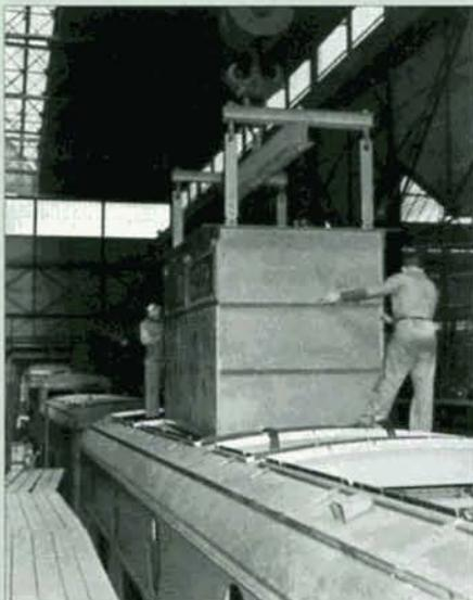
↑ Mise en place du bloc JH préfabriqué dans la caisse de la locomotive. ACEC.
