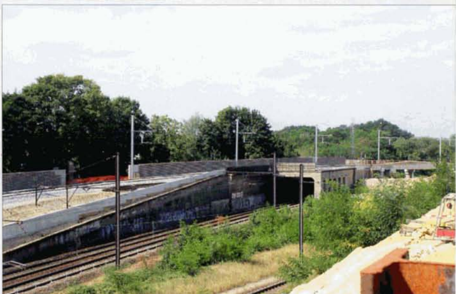
Photo du haut - PHOTO 112-28 Au lieu dit "Moensberg", la ligne 124 passe au-dessus de la ligne 26 à angle droit. Un nouveau pont est en cours de construction pour permettre aux deux nouvelles voies de franchir la ligne 26. L'ancienne cabine de signalisation désaffectée de Linkebeek se trouve au milieu du tracé des futures nouvelles voies et devra être démolie. Un pont provisoire a été posé au-dessus de la ligne 26 pour permettre l'accès au chantier. Un nouveau point d'arrêt sera construit sur ce site, de manière à faire correspondance avec l'actuel point d'arrêt de Moensberg sur la ligne 26 (halte située à une centaine de mètres du croisement des deux lignes, à droite de l'image).
