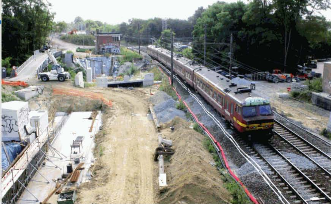
Photo du haut - PHOTO 112-28 Au lieu dit "Moensberg", la ligne 124 passe au-dessus de la ligne 26 à angle droit. Un nouveau pont est en cours de construction pour permettre aux deux nouvelles voies de franchir la ligne 26. L'ancienne cabine de signalisation désaffectée de Linkebeek se trouve au milieu du tracé des futures nouvelles voies et devra être démolie. Un pont provisoire a été posé au-dessus de la ligne 26 pour permettre l'accès au chantier. Un nouveau point d'arrêt sera construit sur ce site, de manière à faire correspondance avec l'actuel point d'arrêt de Moensberg sur la ligne 26 (halte située à une centaine de mètres du croisement des deux lignes, à droite de l'image).
