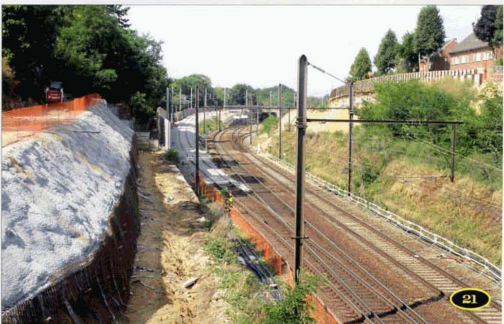
Photo du milieu - PHOTO 112-29 ↗ A droite, on voit la bretelle de la ligne 26/5 passant au-dessus des deux voies de la ligne 124. Cette bretelle, après avoir franchi la ligne 124, passe au-dessus de la ligne 26 avant de la rejoindre. A gauche, on remarquera le nouveau pont qui enjambera les deux nouvelles voies.
