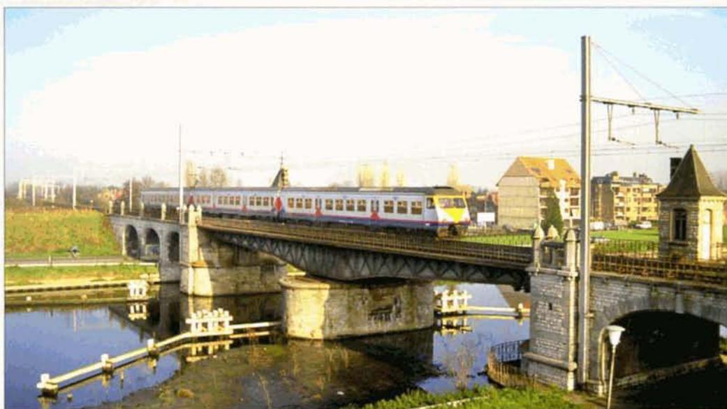
➤ L'ancien pont *Waggelwater* était particulièrement esthétique. A l'origine, sa travée centrale métallique pouvait tourner pour laisser passer des bateaux. Il fut construit en 1906, lors de la mise en service du nouveau tracé de la ligne Brugge - Blankenberge (voir tracé bleu clair sur la carte publiée à la page 54). Le 12 décembre 1994, passage d'un IC en provenance de Blankenberge. Jean-Luc VANDERHAEGEN.
