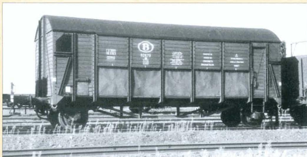
Le wagon de service 92.679 pour le transport de coussinets. Originellement il s'agissait d'un fourgon DR Pwgs-43, transformé par la SNCB en wagon fermé «Bremen», puis en véhicule de service. On remarquera les renforts ajoutés sous le châssis lors de la transformation. Collection Charles OCSINBERG.
