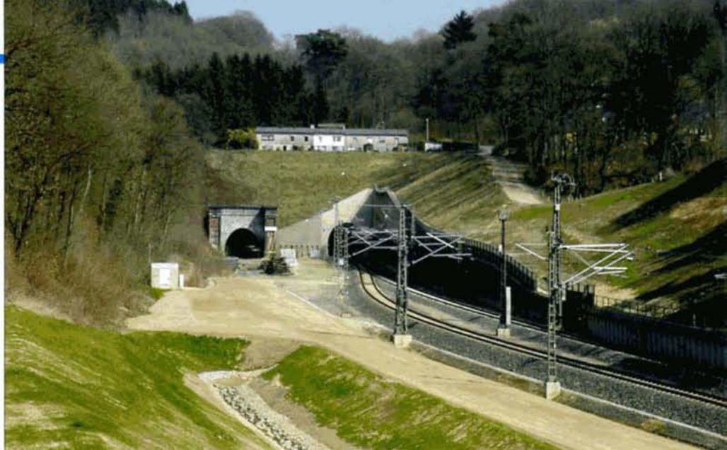
**PHOTO 91-62** Une vue de la situation actuelle du Buschtunnel à Aachen (ligne Aachen - Welkenraedt), prise côté belge le 3 avril 2009. Après assainissement de l'ancien tunnel à gauche, la seconde voie y sera reposée. Marc DERIEUX.
