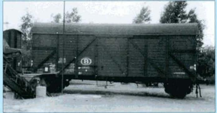
Le wagon fermé SNCB 4.416.953 type 2021, ex. DR type Gmhs «Bremen» avec passerelle de frein. Des variantes existaient au niveau des marchepieds et des portes. Collection Charles OCSINBERG.
