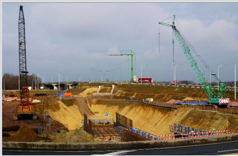
4 A hauteur de l'échangeur autoroutier de l'E19 à Machelen, les travaux sont rendus très complexes, vu que le trafic routier ne peut être interrompu pendant les travaux, nécessitant la construction des tunnels par petits tronçons. Ici, on voit une partie de la bifurcation vers Mechelen, sur laquelle est établie une bretelle d'entrée et de sortie de l'E19 vers Mechelen.
