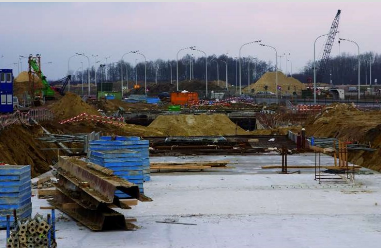
1 Nous nous trouvons au-dessus du tunnel venant de la gare de Bruxelles-National-Aéroport (la gare est situé dans notre dos). Au milieu de l'image, on distingue deux pertuis : celui de droite permettra d'aller vers Mechelen, celui de gauche vers Schaerbeek.
