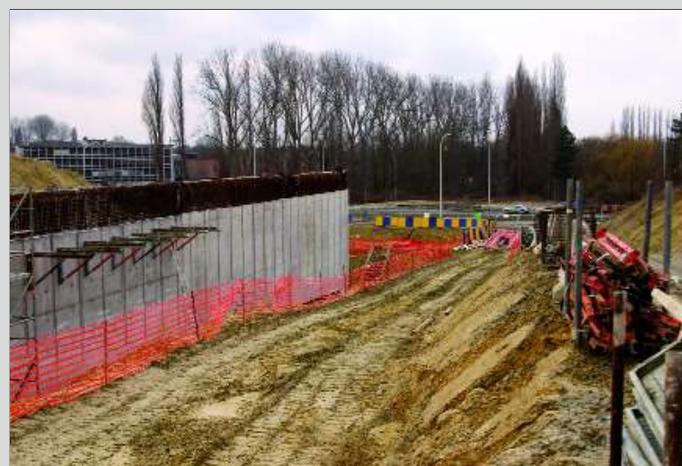
10 Dans le prolongement des murs sera construit le viaduc au-dessus de l'avenue de Woluwé, laquelle est visible au milieu de la photo. La ligne 26 (ceinture est de Bruxelles) et les terrains de Schaerbeek-Formation ne sont pas loin de ce site.
