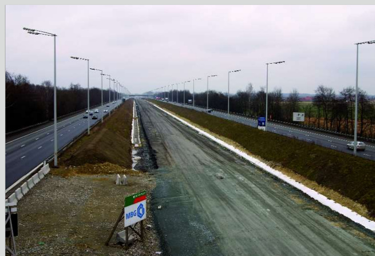
8 En direction de Mechelen, les travaux de terrassement de l'assiette de la L25N sont bien avancés.
