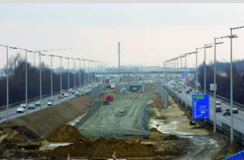
7 Un peu plus loin vers Mechelen, cette vue a été prise en direction de Bruxelles. Le tunnel visible au milieu de la photo est situé sous les bretelles de l'E19 à Machelen, permettant d'aller vers l'aéroport. La nouvelle ligne 25N continuera tout droit vers Schaerbeek.
