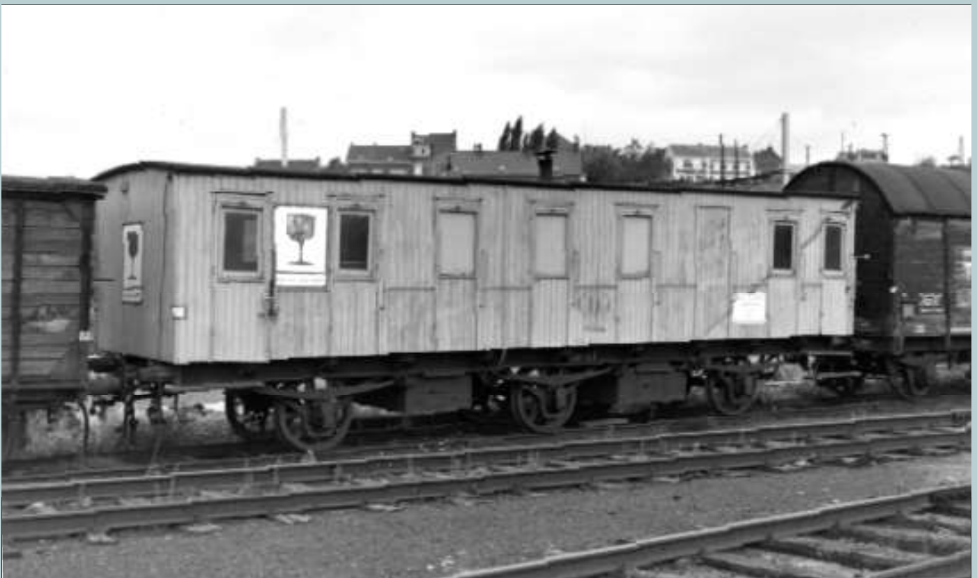
PHOTO BD-314 Le véhicule de service 190.044 utilisé par le service ES (Electricité et Signalisation) à Ronet. Il s'agit d'une ancienne GC de la série 4322 à 4718, de 3e classe (C57) à 8 compartiments avec couloir latéral et pourvue d'une toilette. Ronet, le 12 septembre.1962. Bruno DEDONCKER, collection PFT ©.
