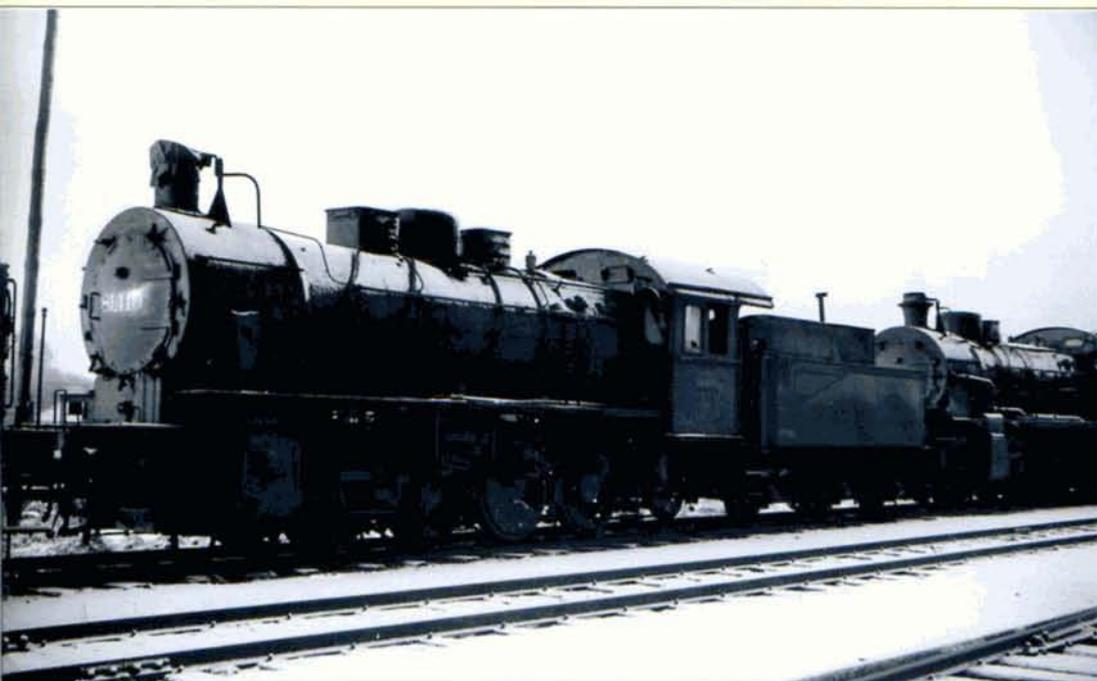
Quatre types de locomotives furent rassemblés à Tournai : des 29, 53, 64 et 81. Ici, la 81.419. Cette G8.1, construite par HANOMAG en 1918, fut mise en service par les Chemins de fer prussiens sous le matricule "Hannover 5325". Cédée à l'Etat Belge, elle porta d'abord le numéro 8519, puis 81.419. Ses trois derniers dépôts furent ceux de Luttre, Walcourt et Monceau, où elle fut radiée en octobre 1966.
