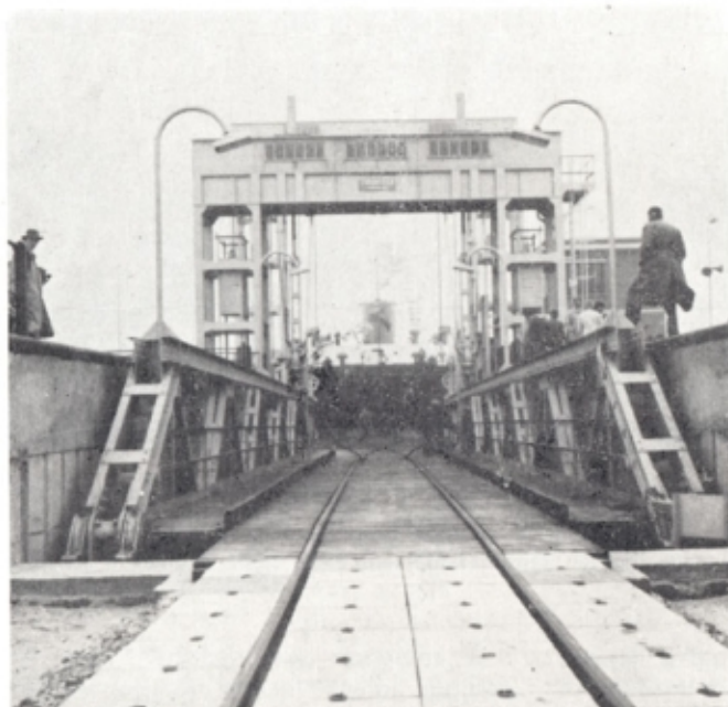
Origine de la rampe d'embarquement un ferry-boat étant accosté; au premier plan on remarque de part et d'autre de l'ouvrage, les rotules d'articulation.
