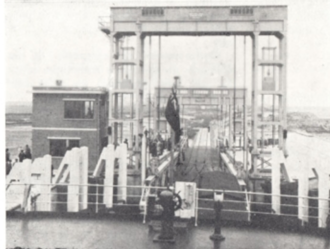
L'enfilade de la rampe réglable vue du pont supérieur du ferry-boat; à gauche du portique, le poste de commande pour la mise à hauteur correcte de la rampe en fonction de la marée.
