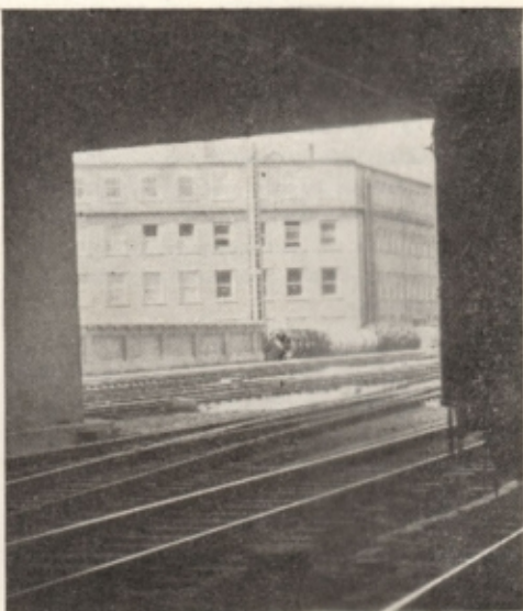
Sortie Nord de la Jonction Nord-Midi, servant provisoirement de garage aux rames de la S.N.C.B. (Photos H.F. Guillaume)
