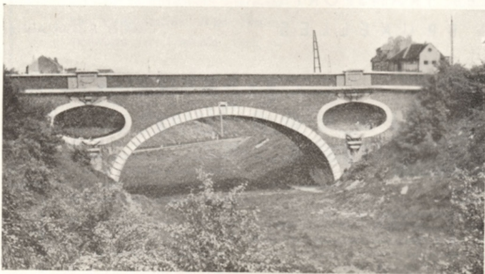
Pont sur le raccordement non réalisé de la ligne de Tervueren vers Schaerbeek - au fond, la ligne de Linkebeek à Anvers (Nord) électrifiée en 3.000 volts continus. (Photo H.F. Guillaume)
