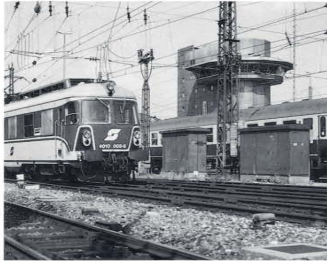
Wahrzeichen des Hauptbahnhofs München: Hackerbrücke mit Zentralstellwerk
