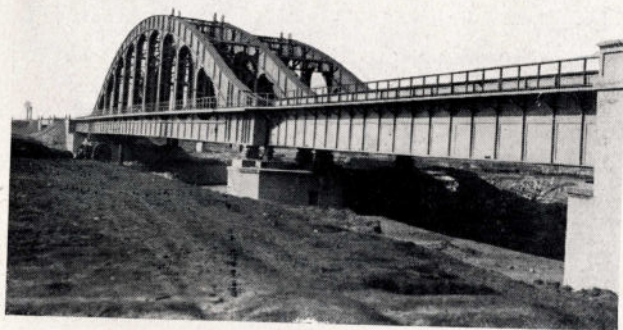
Photo 21 — Pont-rail type Vierendeel
