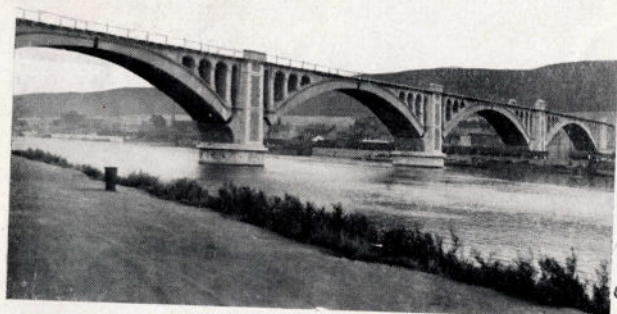
Photo 20 — Pont-rail avec arcs à 3 rotules
