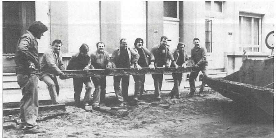
Een, twee, hop! Met duidelijk door de fotograaf geïnspireerd enthousiasme worden door de ploeg van Camiel Everaert de stukgelaste rails op de bulldozer geheven. 61,45 kg per meter a.u.b.!
