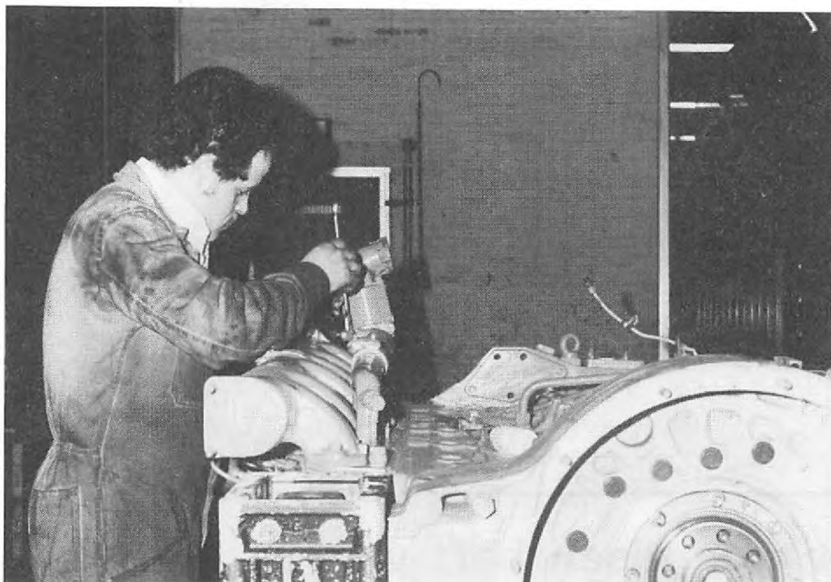
Willy Glibert en zijn koppakkingen : door het bijna fulltime gebruik van de motor wordt het regelmatig vervangen van dichtingen tussen de verschillende elementen een hele klus.
