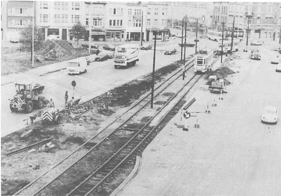
Een algemeen zicht op de werken. Links bemerkt men nog de oude bocht, bijna volledig afgebroken.
