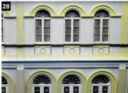
28. Détail des seuils de fenêtres qui se prolongent sur toute la façade.
