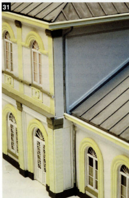
31. Détail des décharges d'eau pluviales.
