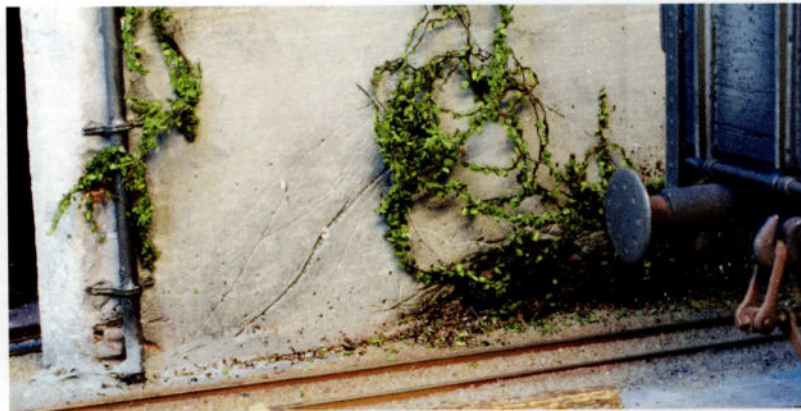
La végétation sur les façades de l'installation d'imprégnation.
