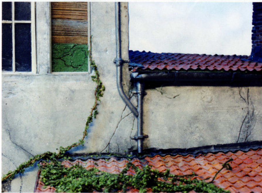
Détail des descentes d'eau sur l'installation d'imprégnation des bois.
