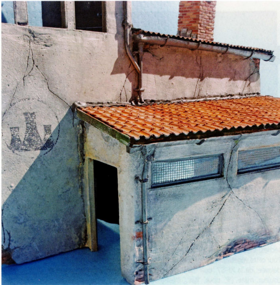
L'installation d'imprégnation est déjà un peu plus avancée.
