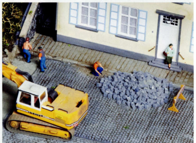
La repose de pavés par l'entrepreneur local.
