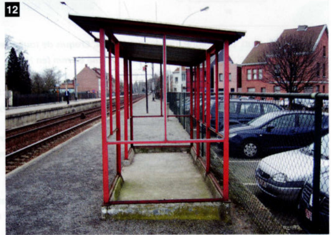
12. L'armature d'une aubette démunie de ses parois, ce qui permet de bien comprendre l'assemblage. Remarquez également la patine verte du béton.
