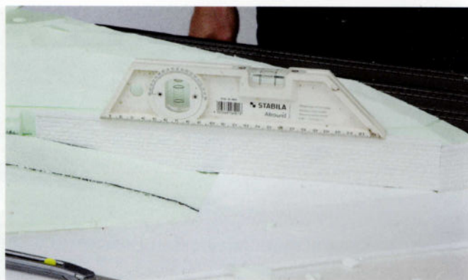
Un niveau d'eau est indispensable pour contrôler si le mur est vraiment horizontal.
