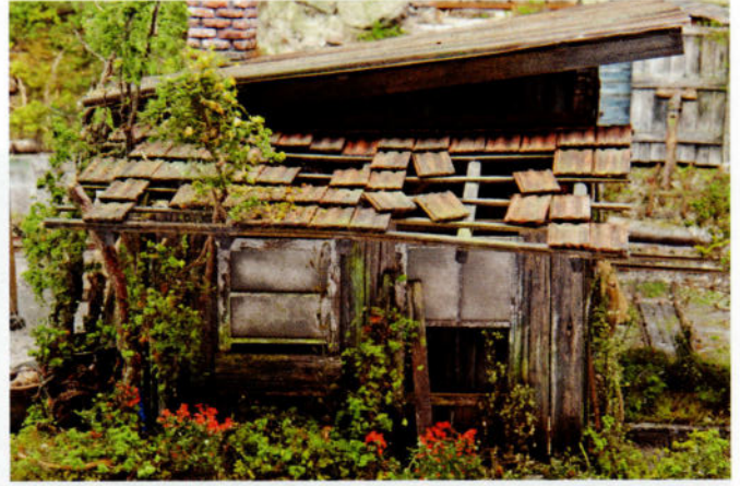
D'un point de vue architectural, tout est réaliste, selon l'architecte Marcel Ackle : c'est sur le point de s'effondrer. Les tuiles du toit sont en terre véritable.
