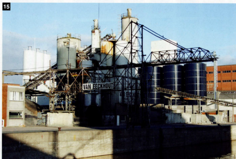
15. Une vue de la véritable firme Eeckhout, installée le long du canal Roulers – Lys.
