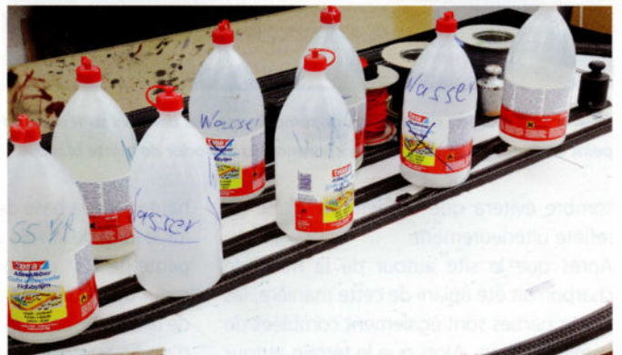
13. Une solution simple pour le pressage des voies lors du séchage de la colle: des bouteilles remplies d'eau.
