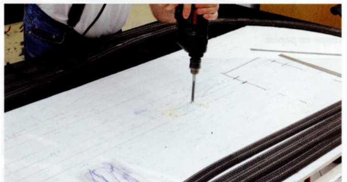
11. Après le forage des trous dans les quatre coins, l'ouverture dans la plaque de base peut être découpée.
