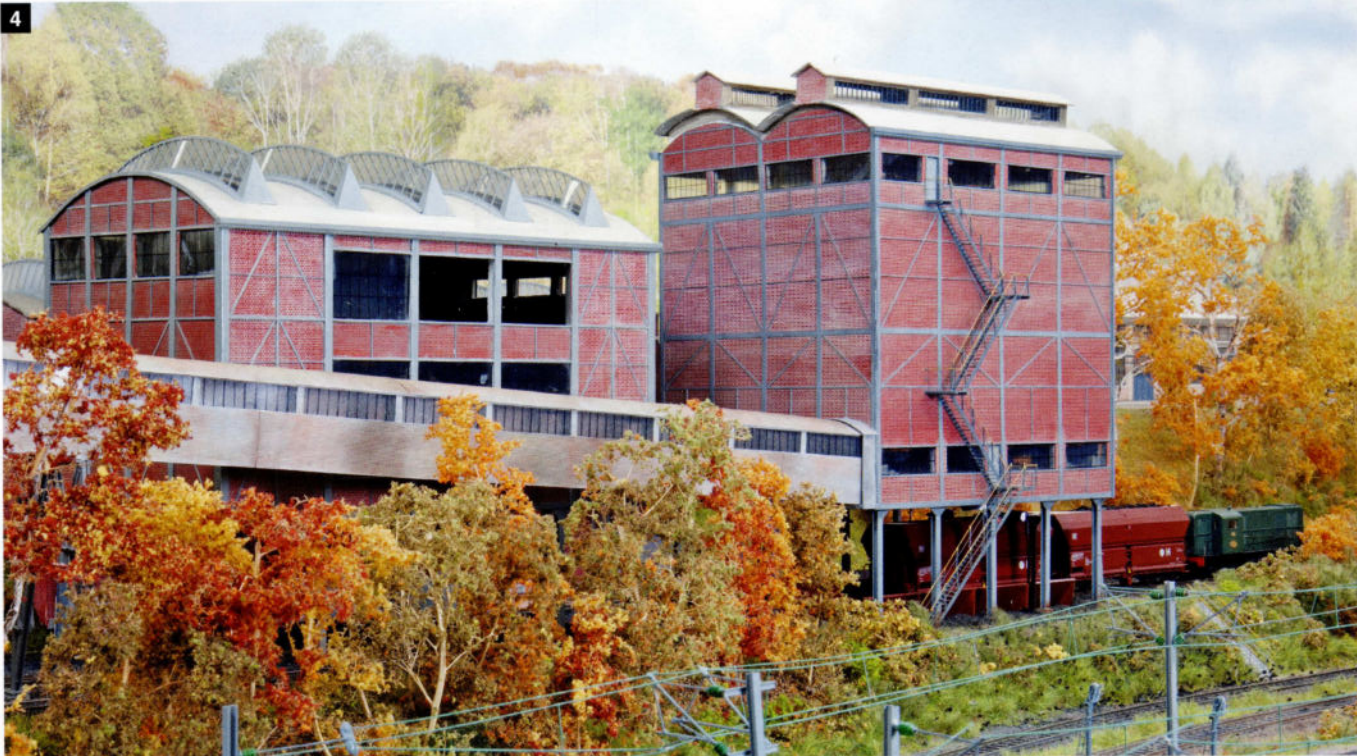
4. Dans le bâtiment du lavoir, le charbon est séparé des roches et des pierres extraites. Le charbon est ensuite trié et versé dans les wagons tombereaux.
