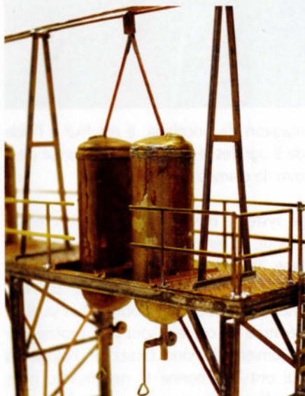
29. Conduite d'alimentation divisée au départ de la boîte de distribution.
