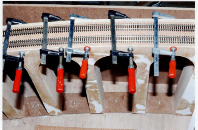
Le viaduc en forme de 'S' répond aux normes NEM pour les modules. Les parties de viaduc sont assemblées avec des clous et de la colle pour bois et maintenues par des serre-joints.
