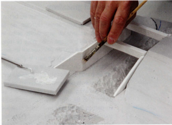
Le matériau superflu est éliminé au moyen d'une petite brosse et d'un peu d'eau. Veillez à ce que la structure du béton reste intacte.
