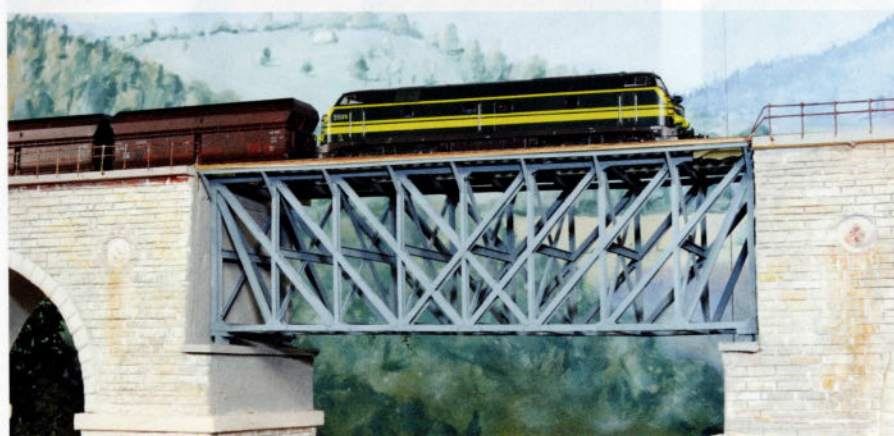
Un petit pont métallique relie les deux parties du viaduc en pierres de taille.
