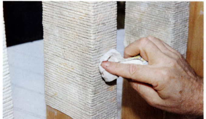
La peinture est frottée avec un chiffon pour obtenir des effets spéciaux.
