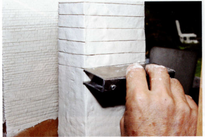
Les joints horizontaux sont enfoncés dans l'argile au moyen d'une règle ou d'une toute autre latte droite.
