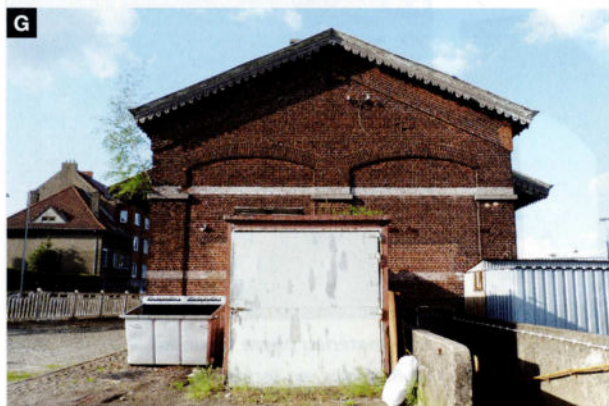
g. De la belle ouvrage que ces jeux de maçonnerie: un régal pour le modéliste observateur et inventif. Voyez aussi les bandeaux horizontaux en briques plus claires.
