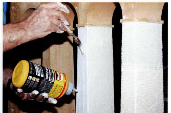
La pile est enduite de colle pour bois non diluée.
