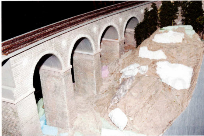
La mousse dure disparaît sous la couche de pâte de fibres. Des rochers sont intégrés dans le plâtre, à certains endroits.
