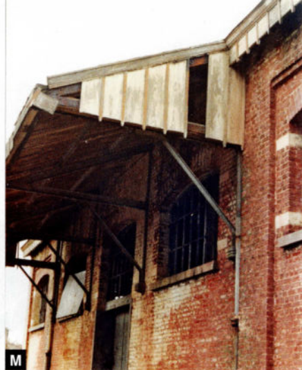
m. La marquise de Uccle-Stalle, aux détails particuliers des corniches en planches.
