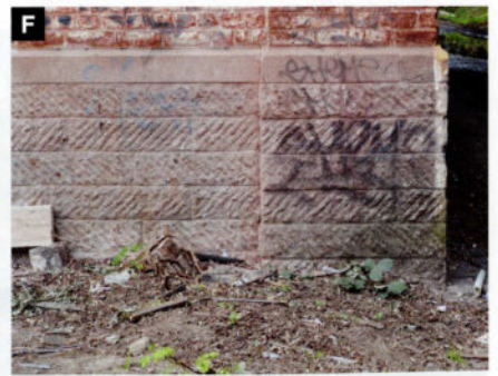
f. Le matériau pierre bleue est le maître choix en Belgique, en termes de soubassement. Celui de Uccle-Stalle est composé d'assises régulières de larges éléments striés.
