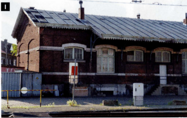
I Retour à Braine-le-Comte pour une toiture en zinc typique. Voyons y surtout les lés successifs du métal, juxtaposés tant verticalement que latéralement, et la résille continue des couvre-joints.
