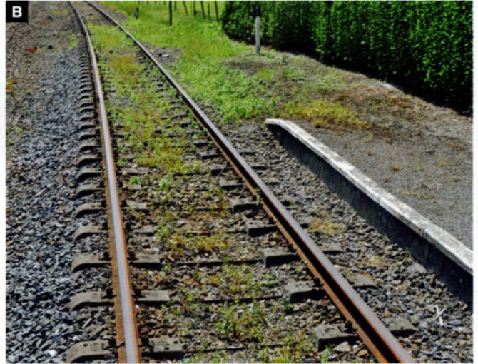
A et B: Sur la ligne du Bocq (ligne 128), on trouve encore des traverses bi-blocs; sur un lit de ballast bien entretenu, les entretoises de liaison sont à peine visibles. Braibant, le 4 juillet 2011. Photo: François-Xavier Leemans
