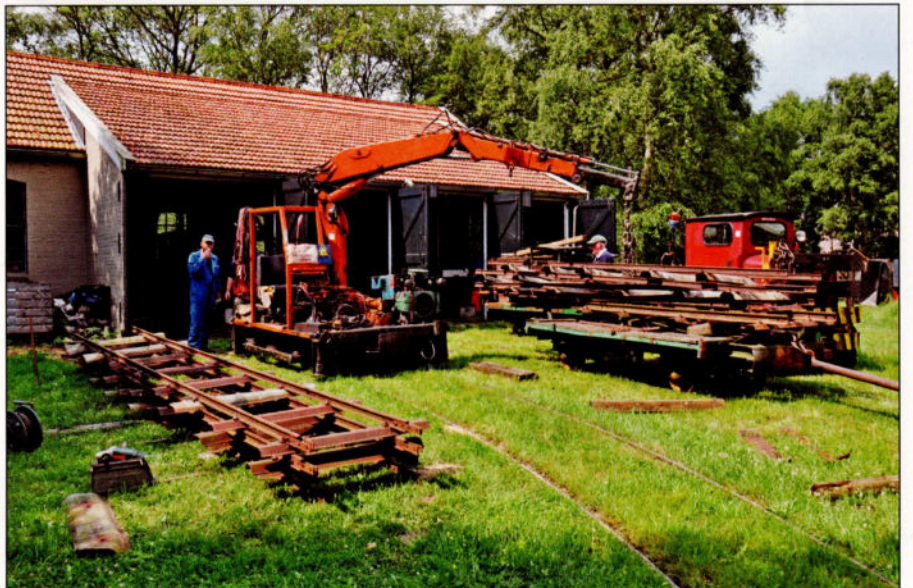
Les travaux menés à l'ancienne remise historique.
