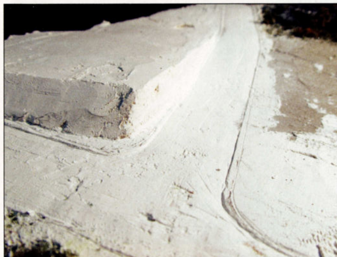
La route pavée prend forme et présente un profil légèrement bombé.
