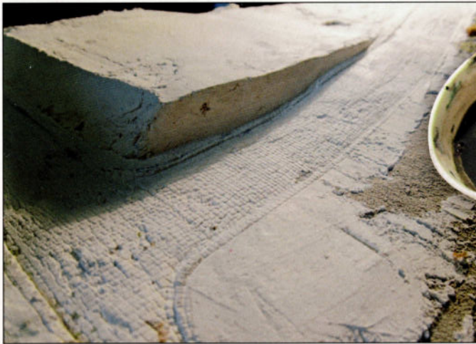
La route pavée est désormais gravée et les bordures ont été posées.
