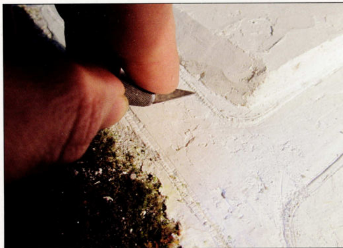
Les bordures sont gravées l'une après l'autre dans le plâtre.
