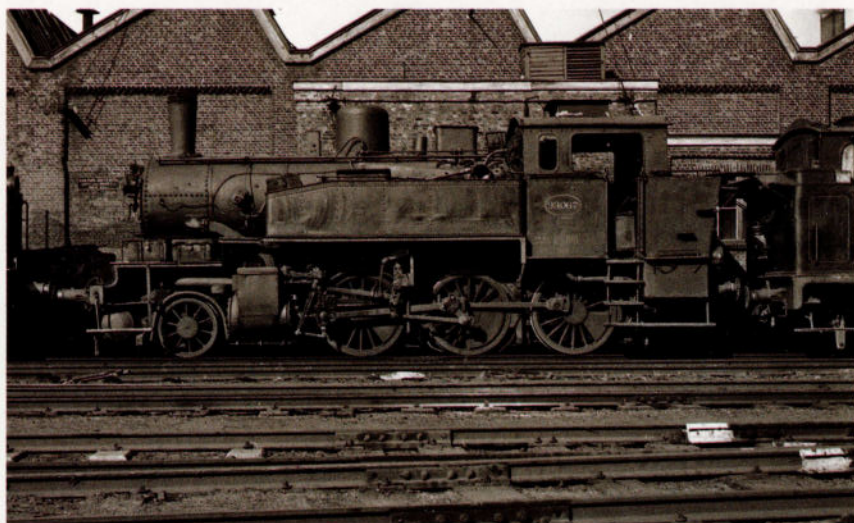
R.C. Riley photographia la 93.067 à Anvers-Dam, le 4 septembre 1949. On voit bien sur cette photo l'emplacement et la taille des marchepieds pour manœuvres (photo: Collection Max Delie)
