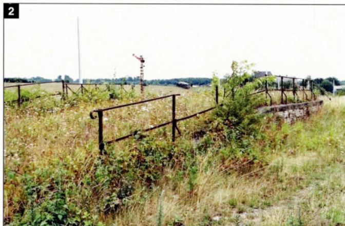
Photo 2: Autre vue de la rampe de Pondrôme. On remarque les rambar- des métalliques. Photo: Alain Bauwin.
