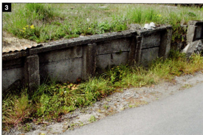
Photo 3: Les parois de la rampe en béton préfabriqué.
