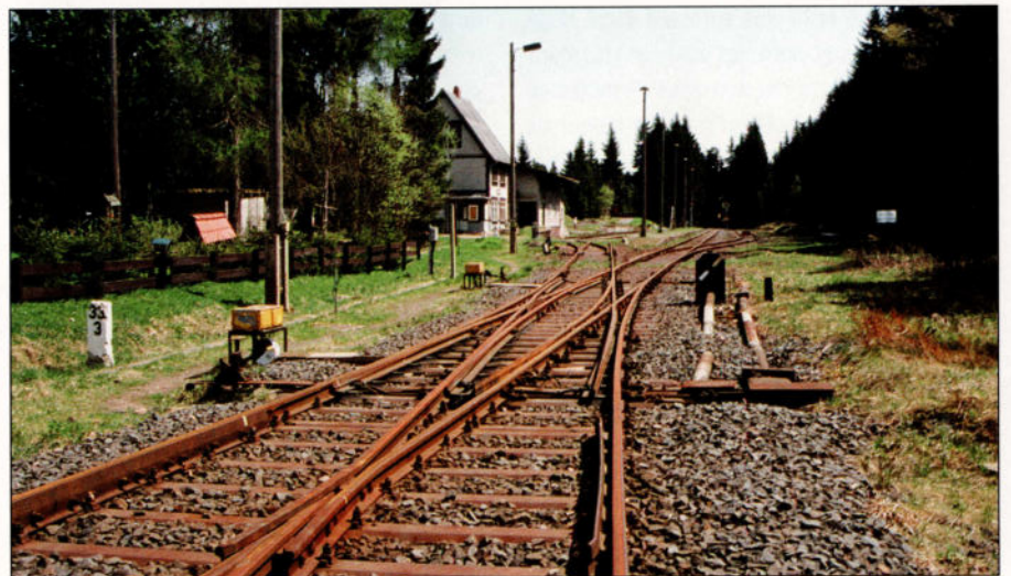
Élément remarquable sur le site de Rennsteig: les deux voies d'entrée se rejoignent sur une traversée-jonction.
