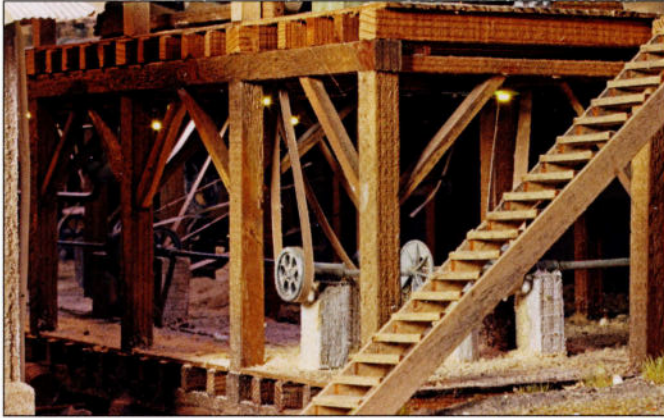
La motorisation des machines-outils, avec ses courroies et ses poulies sous le plancher, la scierie étant au-dessus.
