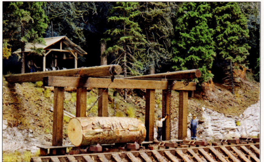
Depuis la balustrade du 'log dump', une chaîne passe sous les troncs vers la poutre supérieure. Quand le treuil (installé dans le bâtiment entre les arbres) tirera sur la chaîne, le tronc sera basculé du wagon.
