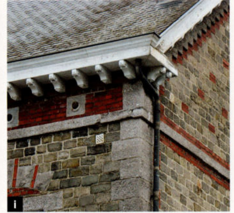
Photo i: Vue rapprochée de la gare de Spontin. Le grès verdâtre domine, intégrant de nombreuses nuances de teintes.
