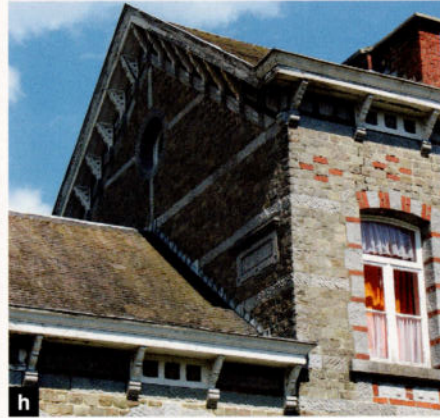
Photo h: Retour sur la jolie gare de Hour-Havenne, à la maçonnerie très travaillée pour l'édifice d'une humble halte.
