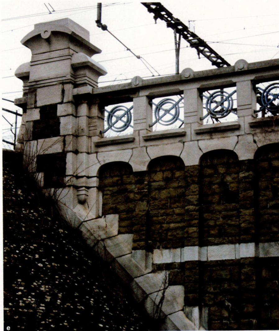
Un tel aplat de couleurs, se retrouve ici, à Gand, où le grès de ce pont-rail présente une tendance verdâtre, complété au niveau des piliers d'une nuance rouge. Comme toujours dans ce genre d'ouvrage d'art en Belgique, c'est la pierre bleue qui y joue le rôle structurant.
