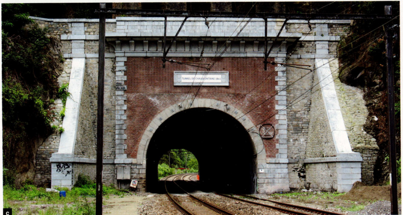
c Le tunnel de Chaudfontaine, sur la ligne de l'Ourthe (ligne 36). Le grès tout venant des contreforts complète l'architecture puissante et maîtrisée du portail, en brique et pierre bleue.
