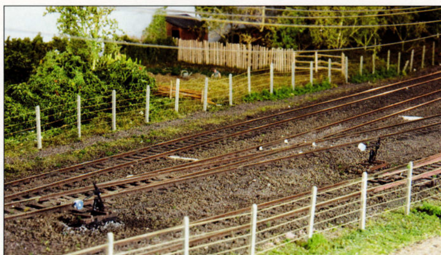
Les excentriques d'aiguillages garantissent grâce à leur masse le maintien des aiguilles dans la bonne position.
