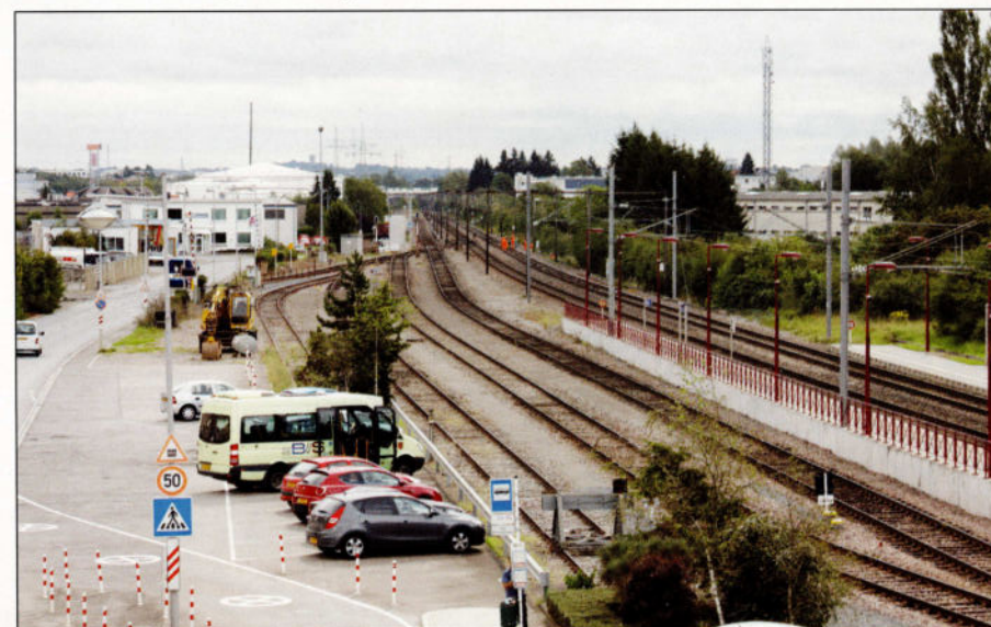
Une vue d'ensemble prise du pont. A l'extrême droite, la ligne 5 des CFL, ensuite les quatre voies de garage et tout à fait à l'arrière-plan, la seconde installation de pompage. La première installation se trouve à gauche, derrière la verdure.
