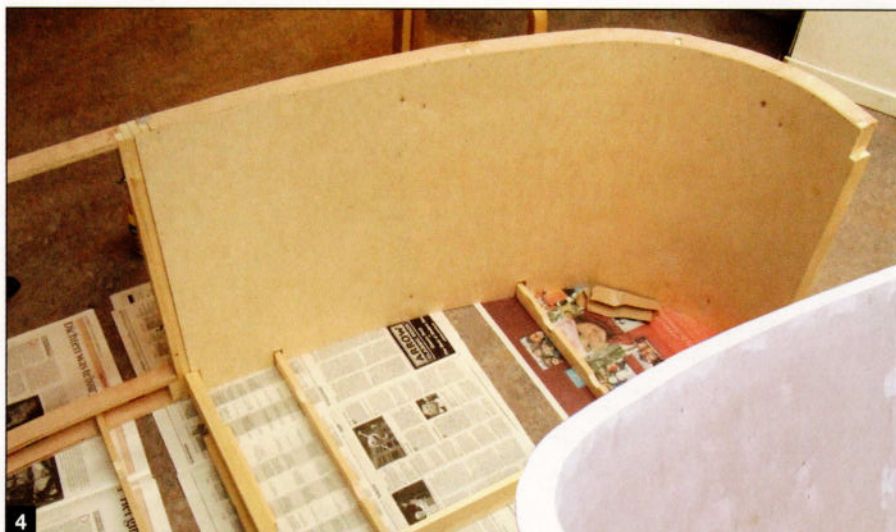
Photo 4 : Un arrière-plan arrondi est plus esthétique, mais nécessite plus de travail.
