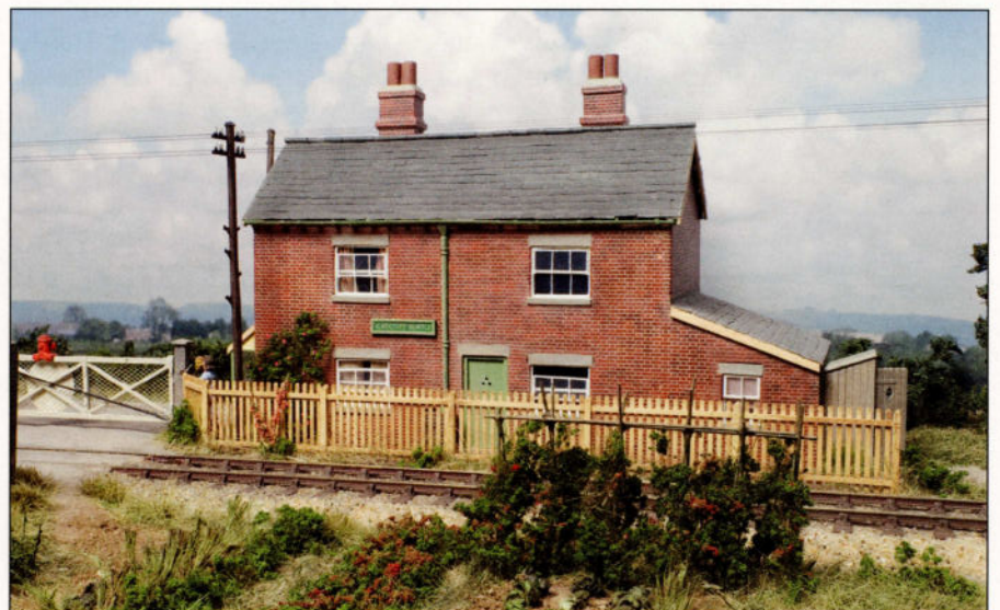
La maisonnette du garde-barrière de 'Catcott Burtle' est une des nombreuses existant le long de la ligne secondaire de Highbridge. Comme elles étaient loin de tout, ces maisonnettes ne disposaient même pas d'eau ni d'électricité. Entre deux passages de trains, le garde-barrière avait tout le loisir de s'occuper de son potager. Le stress n'existait pas encore à l'époque, bien qu'un passage aux toilettes extérieures lors d'une soirée glaciale de janvier ne devait pas être des plus agréables...
