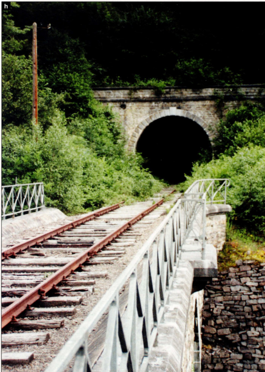
Photo h: Cette vue « ancienne » (1997), encore en mode argentique, d'un viaduc sur le Bocq montre la géométrie du garde corps et des couvre-murs. Remarquons l'élégant retroussé qui les clôture.
