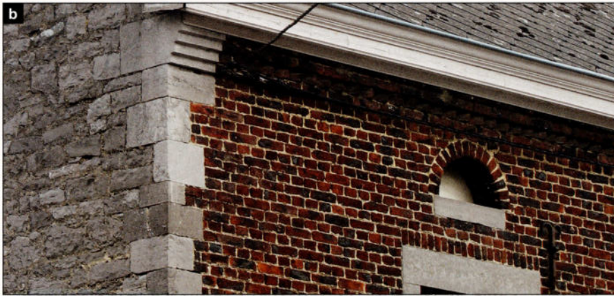
Photo b: La petite fenêtre semi-circulaire apparaissant sur cette construction mixte, rencontrée aux environs de Walcourt, est bien une voûte. Son principe constructif est identique à celui des ponts que nous allons étudier aujourd'hui. En effet, l'analogie est complète entre les humbles briques qui la composent et les éléments similaires réalisés en pierre bleue, appelés claveaux, sur les ouvrages de beaucoup plus grande portée que sont les ponts de maçonnerie. En dessous d'elle apparaît une poutre-linteau en pierre bleue, illustrant le second principe de franchissement d'une portée, autorisé au matériau calcaire du fait de sa résistance à la traction.
