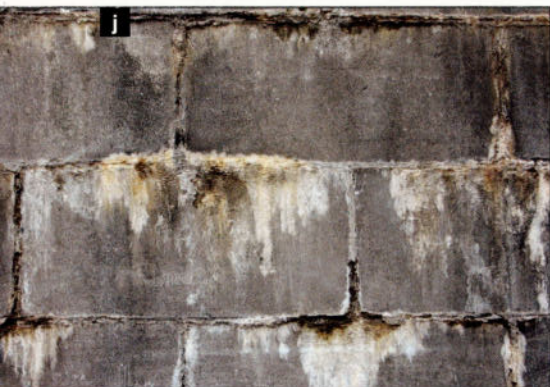
Photo j: Les concrétions calcaires sont le lot commun de ces murs retenant des terres. Les suintements sourdent des joints du parement.
