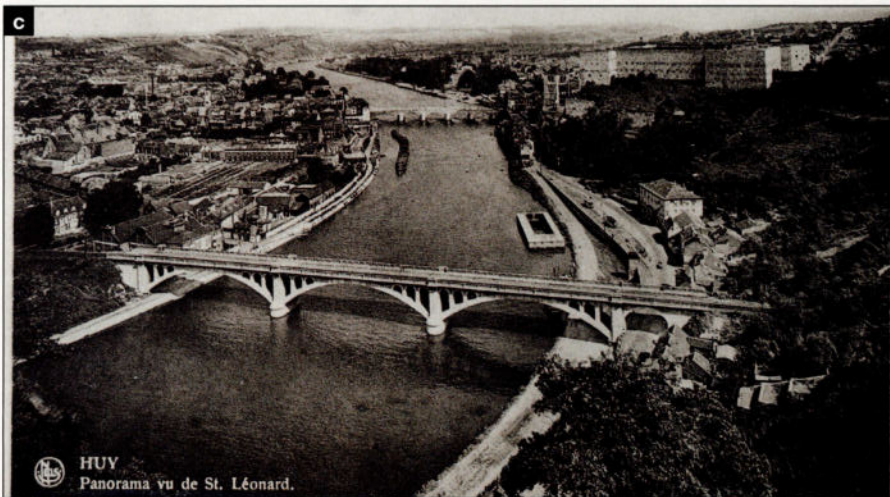
Photo c: Une vue ancienne de la ville de Huy. Le pont ferroviaire au premier plan, enjambant la Meuse, permet à la ligne 126 de rejoindre la vallée du Hoyoux, depuis la gare de Statte. Sa constitution aérée met en évidence la minceur de l'arcade, en regard de la portée franchie. De part et d'autre, des culées de maçonnerie reprennent les poussées au vide générées par ce mode de construction. Remarquons aussi la physionomie d'origine du pont routier.
