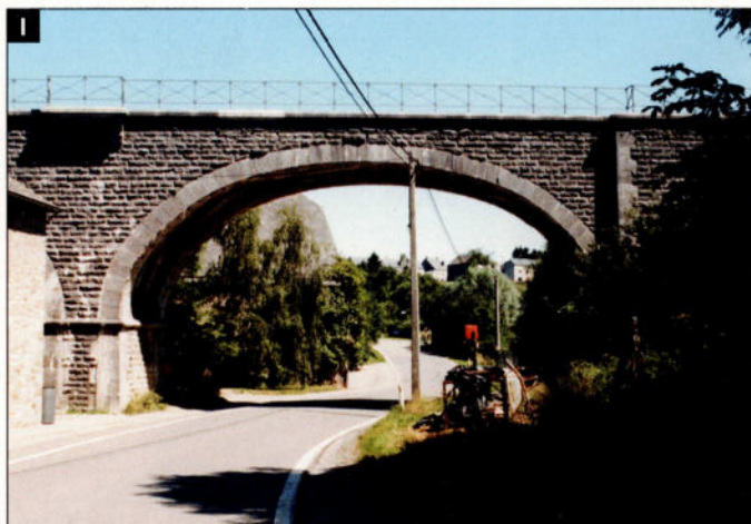
Photo l: Le viaduc de Senenne, sur la ligne 128, présente une voûte de grande portée, estimée à 17m en extrapolant la dimension de la balustrade.
