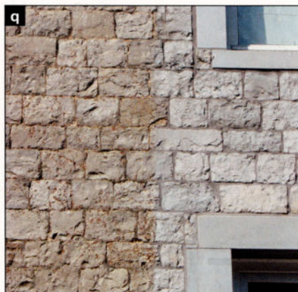
Photo q: Ce cliché, réalisé dans la région de Chimay illustre l'aspect chaud d'une maçonnerie ancienne, et la teinte plus froide et bleutée qu'elle retrouve en étant nettoyée par sablage et rejointoyée. Les encadrements de fenêtre illustrent l'utilisation contemporaine du matériau, en blocs à la surface lissée.
