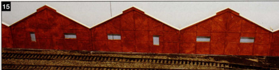
15 : La construction du toit, faite de plaques ondulées.
