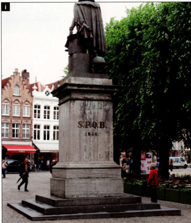
Photo i: Nous sommes ici à Bruges et le socle de la statue de Simon Stevin est bien en pierre bleue. Nous remarquons sur le monolithe central les traces d'une pose en délit, soit perpendiculaire à l'orientation des bancs.
