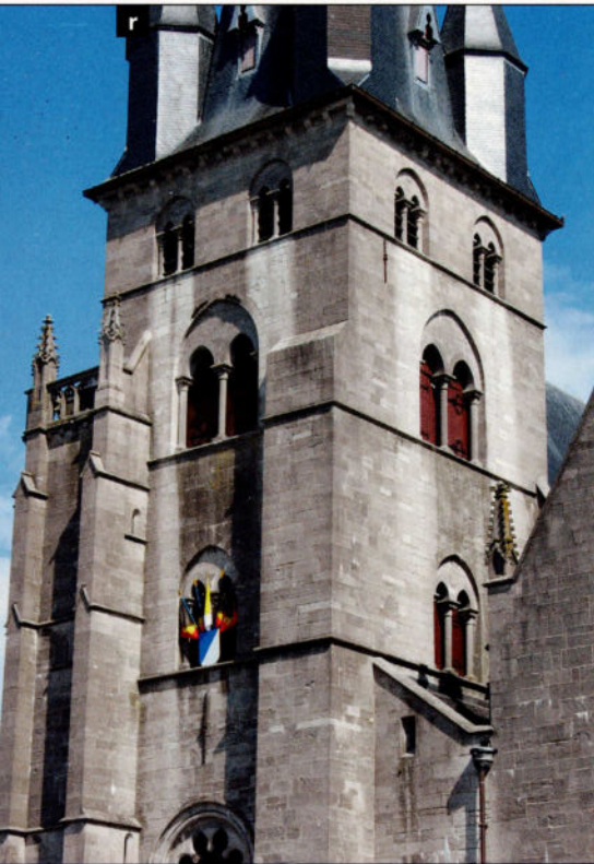
Photo r: L'église de Walcourt, très bel édifice gothique, construit durant la période espagnole. Il présente un parement de pierres équarries où apparaissent de nettes variations de teintes entre les blocs.
