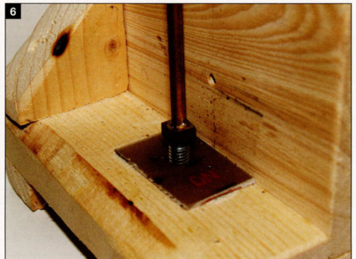
6: Le surplus de soudure pourra être limé par après, comme cela a déjà été fait ici.
