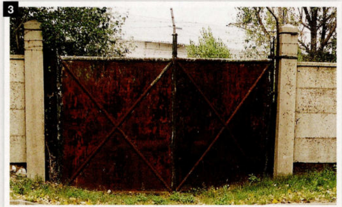
3 Exemple complètement différent avec ce portail « fer » en bien mauvais état, la corrosion ayant pris le dessus de la peinture verte. De construction ultra - simple il va aussi me servir d'exemple pour une réalisation modéliste où je vais lui redonner un peu de couleurs.
