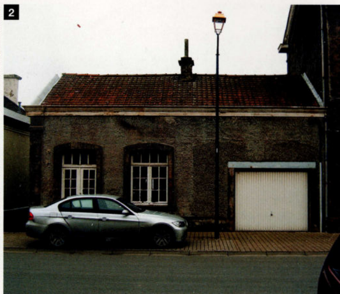
2 La façade de l'ancienne salle d'attente.
