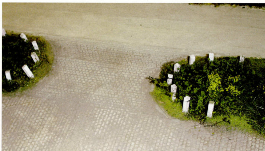
Dans ce cas, un raccord parfait entre les pavés et une ancienne route en béton a été réalisé. Remarquez les différences dans l'utilisation des teintes, bien qu'une parfaite harmonie ait été obtenue entre les deux types de revêtement.
