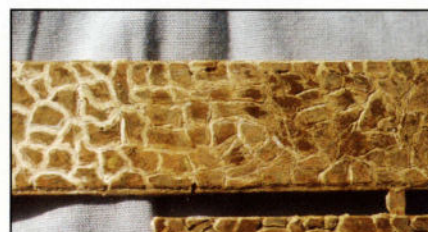
3 3 e étape : le mortier est placé dans les joints
