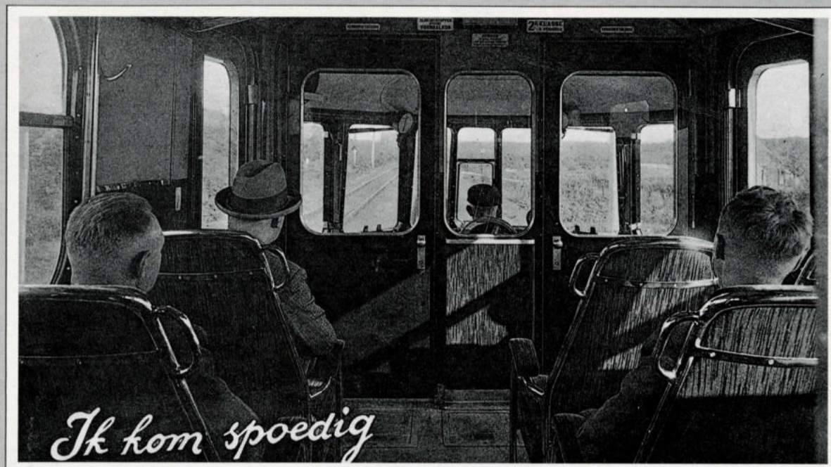
4. Deze Ansichtkaart laat de glazen wand zien tussen de cabine en de afdeling 2e klasse van een omBC.
