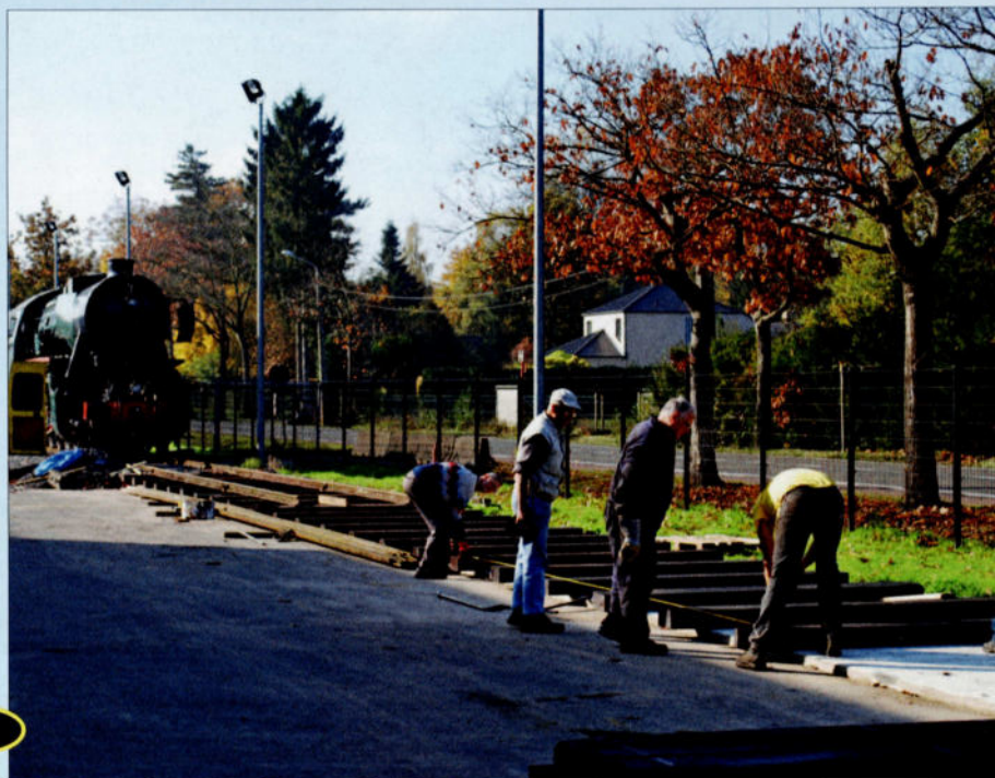
Verlenging van het spoor, uitgevoerd door de CFB-ploeg. TSP.
