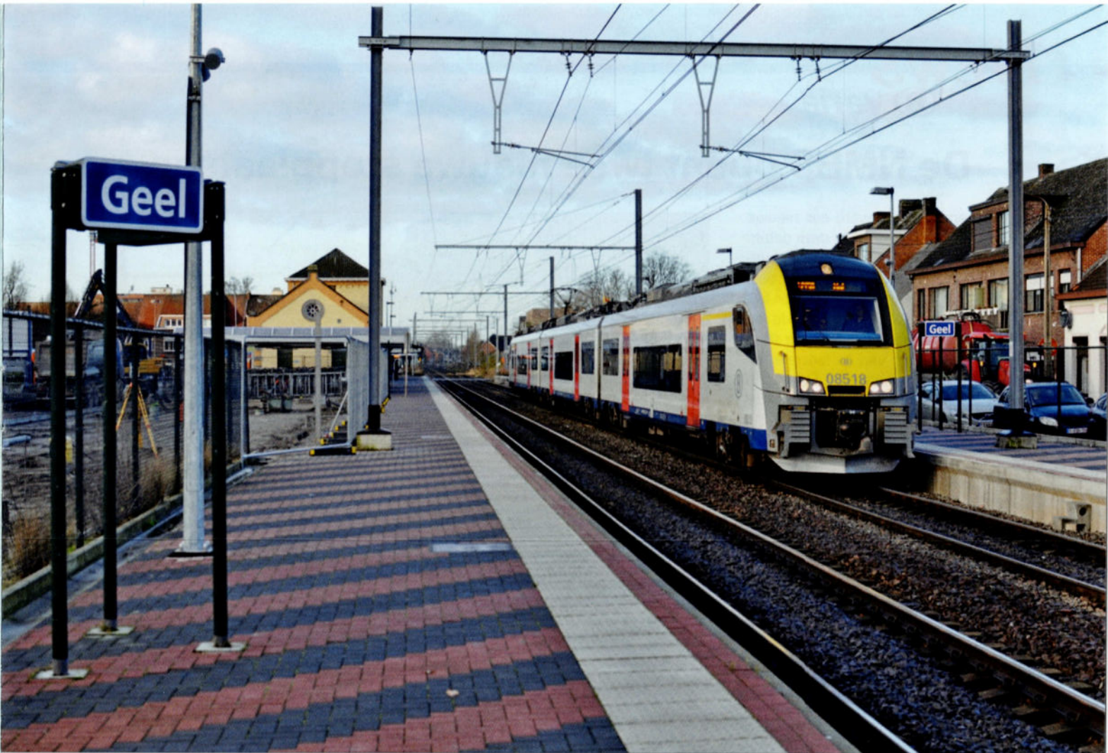
FOTO 131-17 De officiële indienststelling van de elektrische tractie op de lijn tussen Antwerpen-Centraal en Mol gebeurde op 9 december 2015 met de Desiro 08518. Halte in het station van Geel, waar de installaties werden vernieuwd. Johny BRAUNS.
