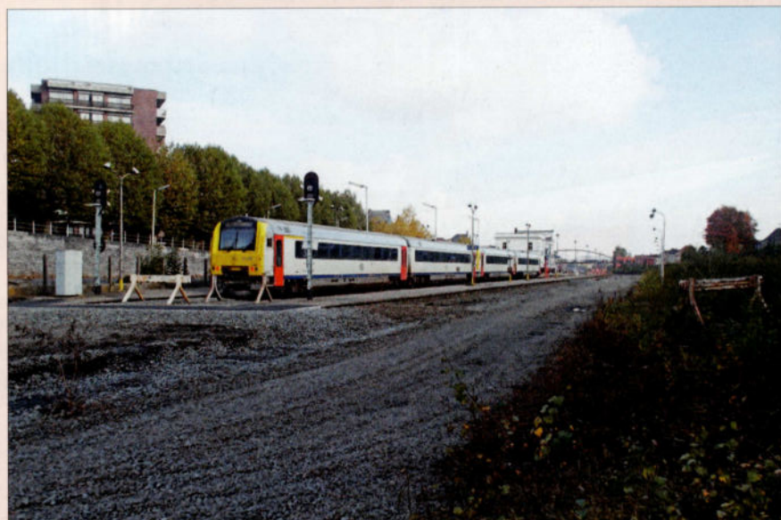
De vereenvoudigingswerken, die Infrabel al meerdere maanden bezig houdt, gaan steeds verder. Dit is wat er nog overblijft van de installaties in het station Ronse: twee doodlopende perronsporen en slechts één wissel... Kristof AVONDS.
