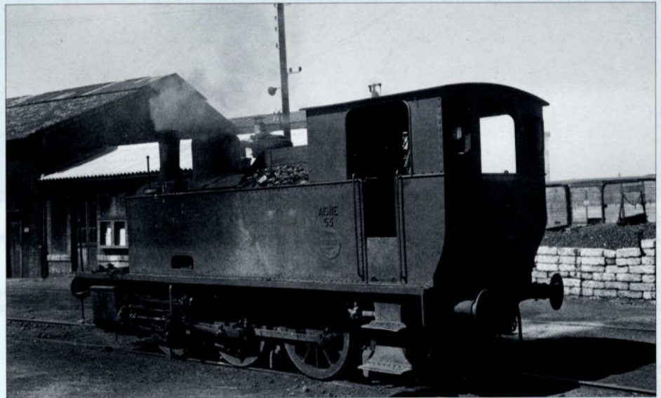
Locomotive-Tender pour industries diverses à 6 roues couplées de 0-950 de diamètre. Poids en service : 32 tonnes.
