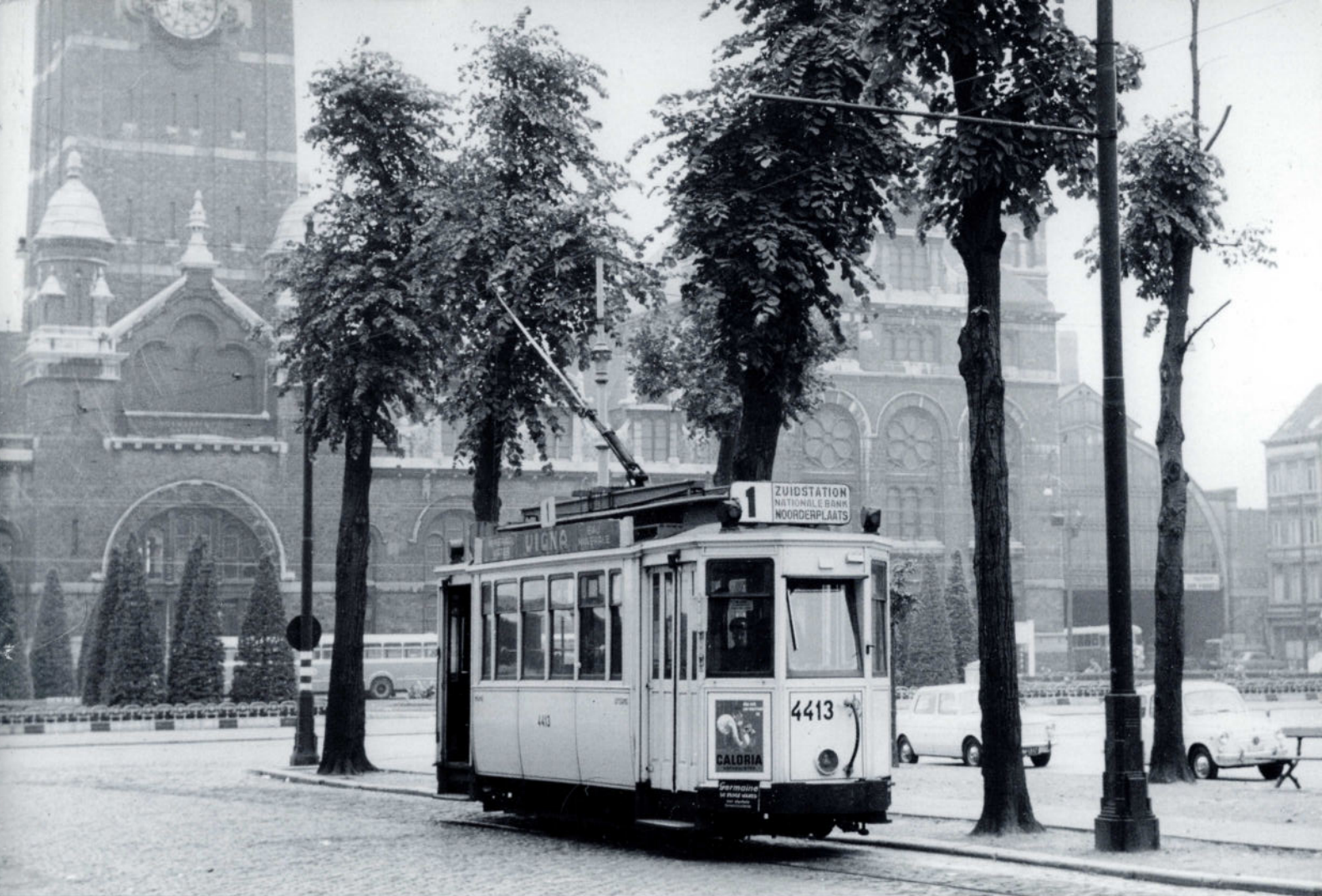
De 413 maakte deel uit van de reeks 404-471. Deze reeks werd tussen 1904 en 1913 door de "CGTA" (Compagnie Générale des Tramways d'Anvers, S.A.) in eigen beheer gebouwd in de centrale werkplaats Grote Hondstraat. In 1963 werd hij door MIVA vernummerd naar 4413. In de periode 1966 - 1968 werd hij verbouwd voor éénmansbediening. De 4413 verdween uit commerciële dienst in 1970 en werd verbouwd tot depannagewagen 5853, later 8853. In oktober 1994 ging hij definitief buiten dienst. Aan het begin van de Amerikalei, op 21 september 1963, heeft de MIVA-motorwagen 4413 de Bolivarplaats aan het station van Antwerpen-Zuid verlaten om naar de Noorderplaats te rijden, het eindpunt van lijn 1. Foto M. STEINKAMP, verzameling TSP.
