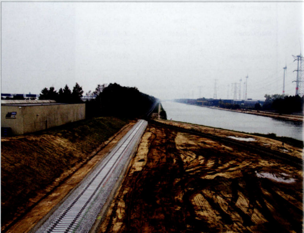
De bruggen over het Albertkanaal worden verhoogd en waarmogelijk wordt het kanaal verbreed voor de inzet van hoger geladen containerschepen. Dit heeft ook gevolgen voor lijn 207: in de buurt van Geel Punt wordt de lijn rechtgetrokken. A. ENGELEN, 13 oktober 2015.
