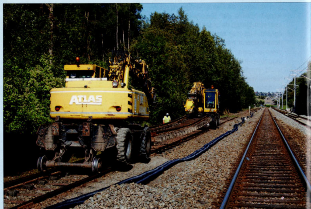
FOTO 130-08 Het opbreken van de lijn 128 tussen Braibant en Ciney gebeurde in zes dagen, met behulp van twee spoor/wegkranen van Arlon. Het spoor werd verplaatst in stukken van 18 m, om opgeslagen te worden voor hergebruik nadien. TSP / CFB.
