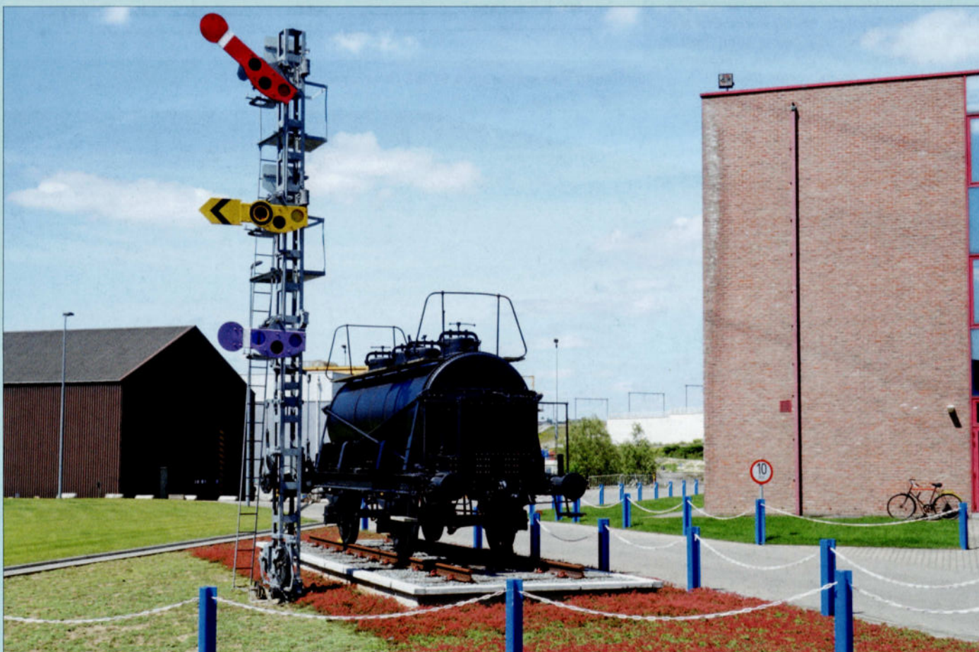
FOTO 130-64 Sinds 2014 is de ketelwagen opgesteld als monument in het Productiecentrum Infrastructuur (PCI) van Schaarbeek. De wagen staat op een stuk spoor, in gezelschap van een mechanisch sein. Pierre HERBIET, 11 juni 2014.
