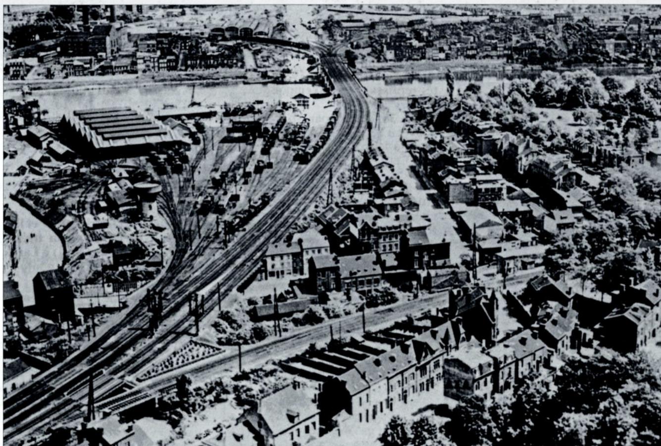
Deze overzichtsfoto toont de uitrit van het station Liège-Guillemins voor 1940. De stelplaats is gesitueerd in de wijk "Fagnée", met de loods met zeven sporen (B), en draaischijf (P.T.). De loods, gelegen in de wijk "Varin"(links) valt buiten deze foto. Vooraan lijn 125 naar Flémalle-Haute en Namur.
