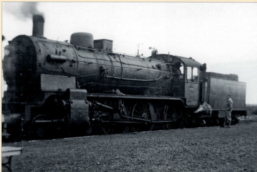
De 6408 werd in mei 1940 te Mons onherstelbaar beschadigd bij een bombardement. We zien haar hier in betere tijden te Knokke in september 1928.
