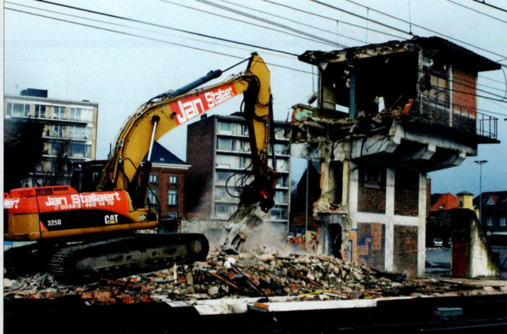
↑ FOTO 127-37 - ↓ FOTO 127-38 Blok 15 maakte deel uit van het station van Braine-le-Comte, samen met de watertoren, die geklasseerd werd als historisch monument. Baudouin DIEU, 14 februari 2015.
