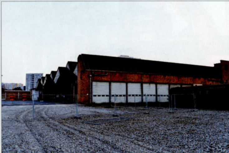
FOTO 127-40 De stelplaats van Leuven verloor het linkerdeel van het gebouw. Na de opbraak van de sporen in 2014, werd dit deel van het gebouw eind 2014 / begin 2015 gesloopt. Pierre HERBIET, 1 april 2015.
