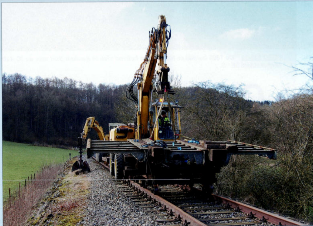
Een kraanwagen plaatste op 5 februari 2014 het brugdek van Spontin op een platte wagen. Nadien werd het ter hoogte van het station overgeladen op een vrachtwagen. TSP.
