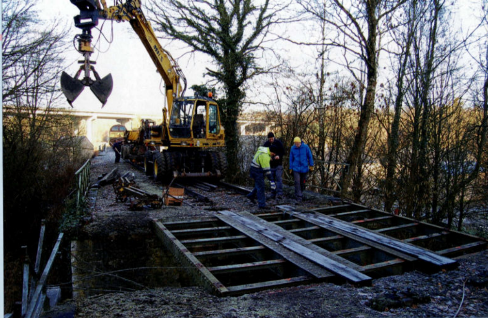
Vorbereiding van de lichtingswerken te Senenne op 2 februari 2014. Hieronder de overbrenging van het brugdek per lorrie naar Spontin. Daar werd het overgeladen op een vrachtwagen. TSP.
