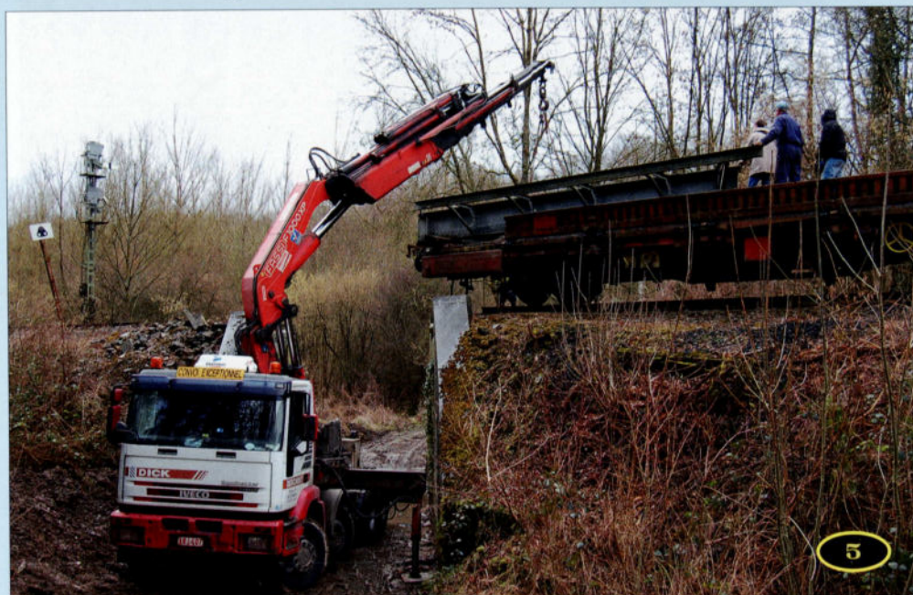
Een kraanwagen plaatste op 5 februari 2014 het brugdek van Spontin op een platte wagen. Nadien werd het ter hoogte van het station overgeladen op een vrachtwagen. TSP.
