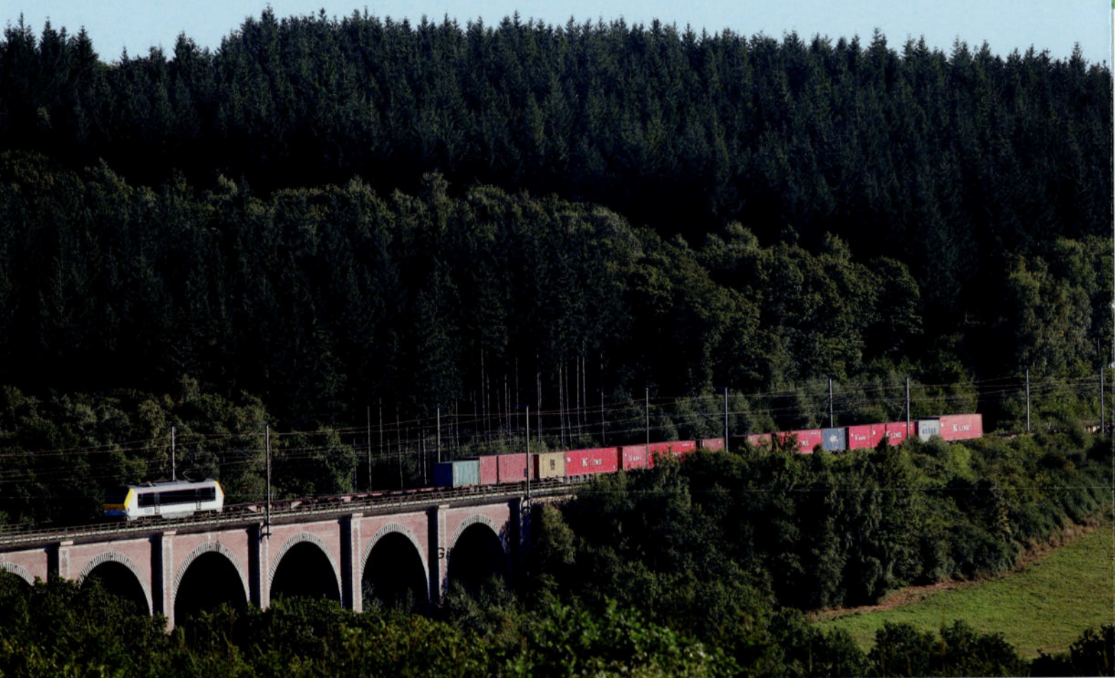
Eén van de indrukwekkendste kunstwerken op de lijn is ongetwijfeld het viaduct van Thanville. We zien hier de 36280 Athus - Antwerpen op 5 september 2013. Gilbert LAURENT.
