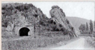
Tunnel de Godinne
