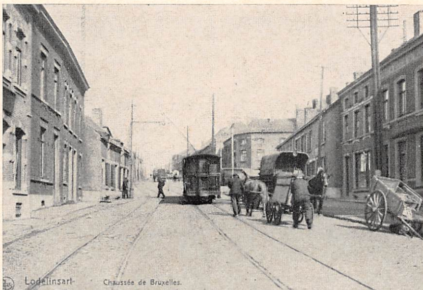
In het begin van deze eeuw waren bepaalde buurtspoorweglijnen voorzien van een bezijden de spoorbaan aangebrachte luchtleiding. De trolley moest dus zijdelings de stroom afnemen, zoals hiernaast op de foto te Lodelinsart.
