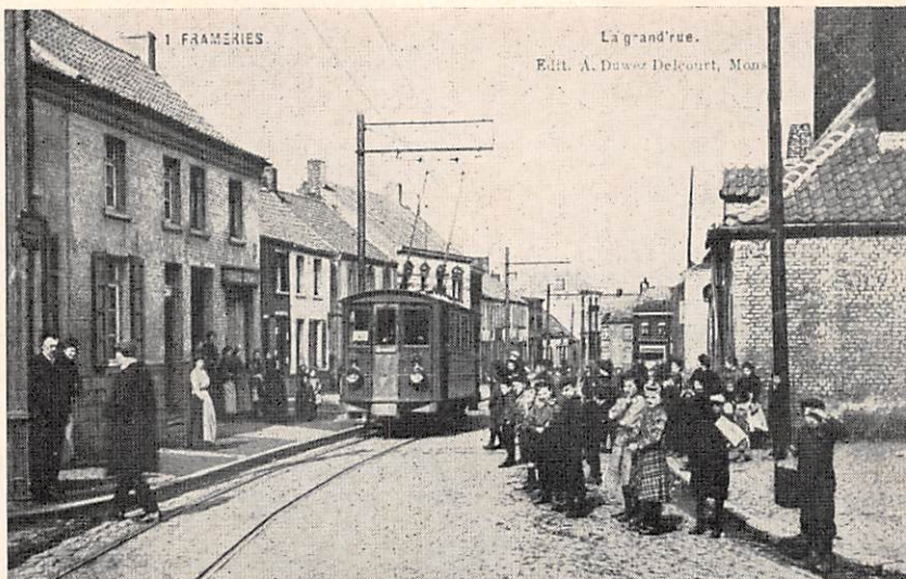
Let op de twee stangen voor stroomafname, type trolleybus.
